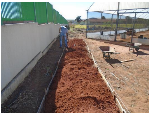
FIGURA 1. Canteiro piloto instalado no Campus Matão.
