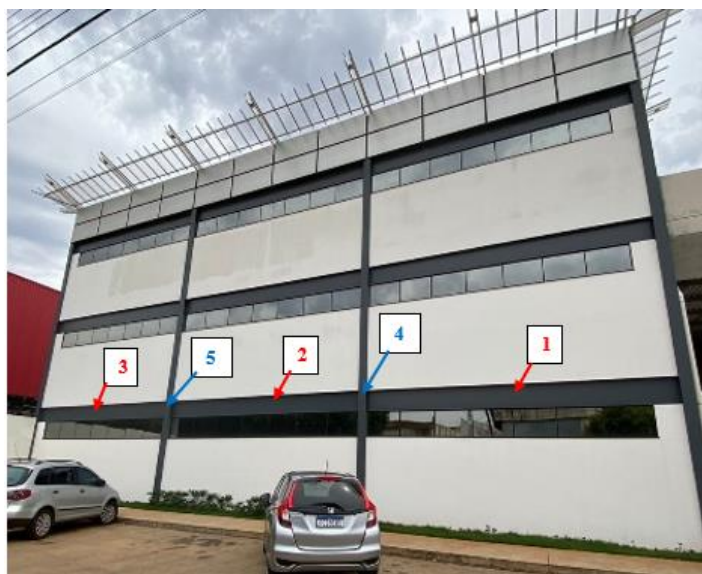
Figura 2: Edifício para a realização das leituras
