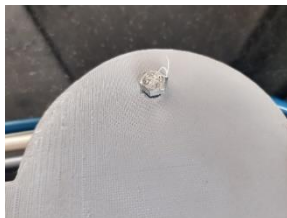
Figura 15 – Desfiamento da estrutura. Fonte: Próprio autor.
