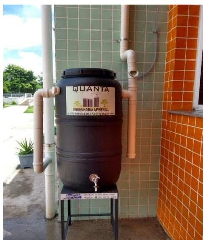
Figura 3. Cisterna criada manualmente e instalada no campus do IF.
