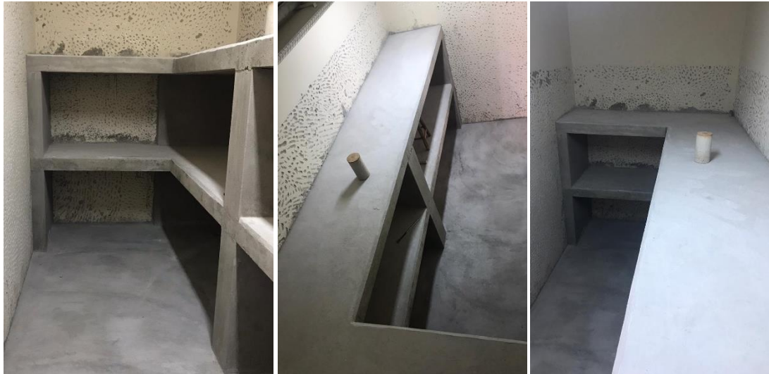
FIGURA 6. Vistas das prateleiras de concreto e do piso já finalizados.
