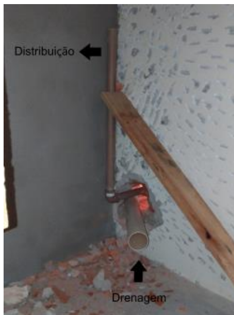
FIGURA 5: Detalhe da entrada da tubulação na câmara
