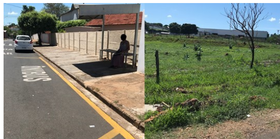
FIGURA 4. Estado de alguns pontos de parada na cidade.
