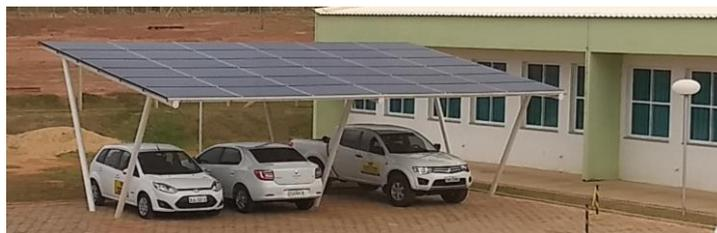
O sistema de geração fotovoltaico começou a operar em maio de 2017, gerando uma média de 40 Kwh por dia, em maio, a geração foi de aproximadamente de 30 Kwh, em junho, foi de 34 Kwh por dia e, em julho, de 37 Kwh por dia.
